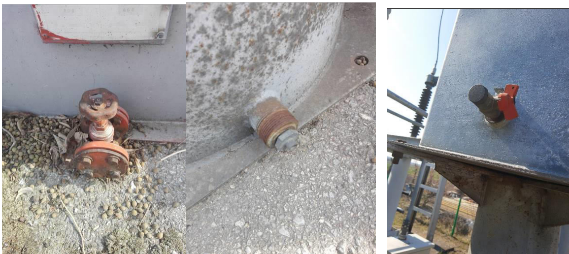
Slika 11 – Stare izvedbe ventila za istakanje (uzorkovanje) ulja
