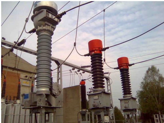
Slika 1 – Prikaz različitih konstrukcionih izvedbi strujnih transformatora 110 kV
